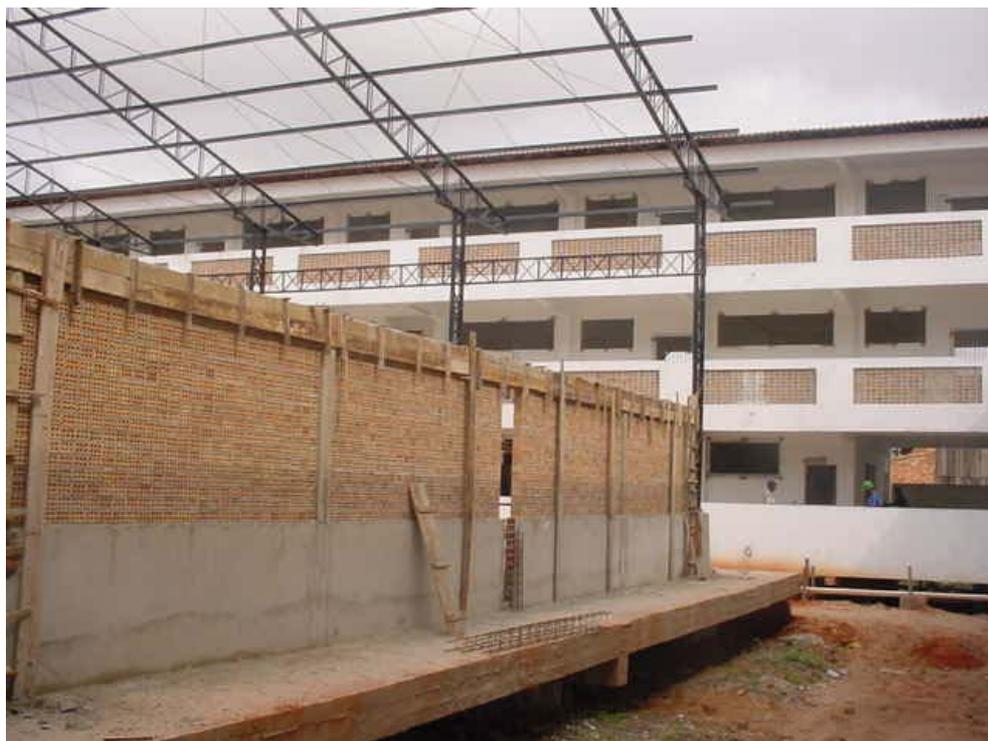
Figura 7.5. Unidade educacional de Belém, dimensão da edificação e construção de quadra polivalente. Identificação da movimentação de terra ocorrida para execução dos projetos estruturais e a presença de laje de sustentação dos blocos.
