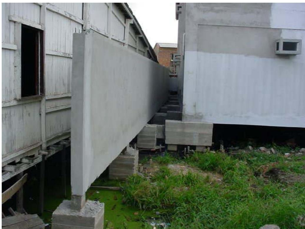
Figura 7.4. Unidade educacional de Belém, adequação do projeto de fundação às características físicas do terreno onde a unidade está inserida e a presença de blocos sobre as estacas de concreto.
